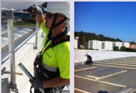
Revisión de instalaciones
